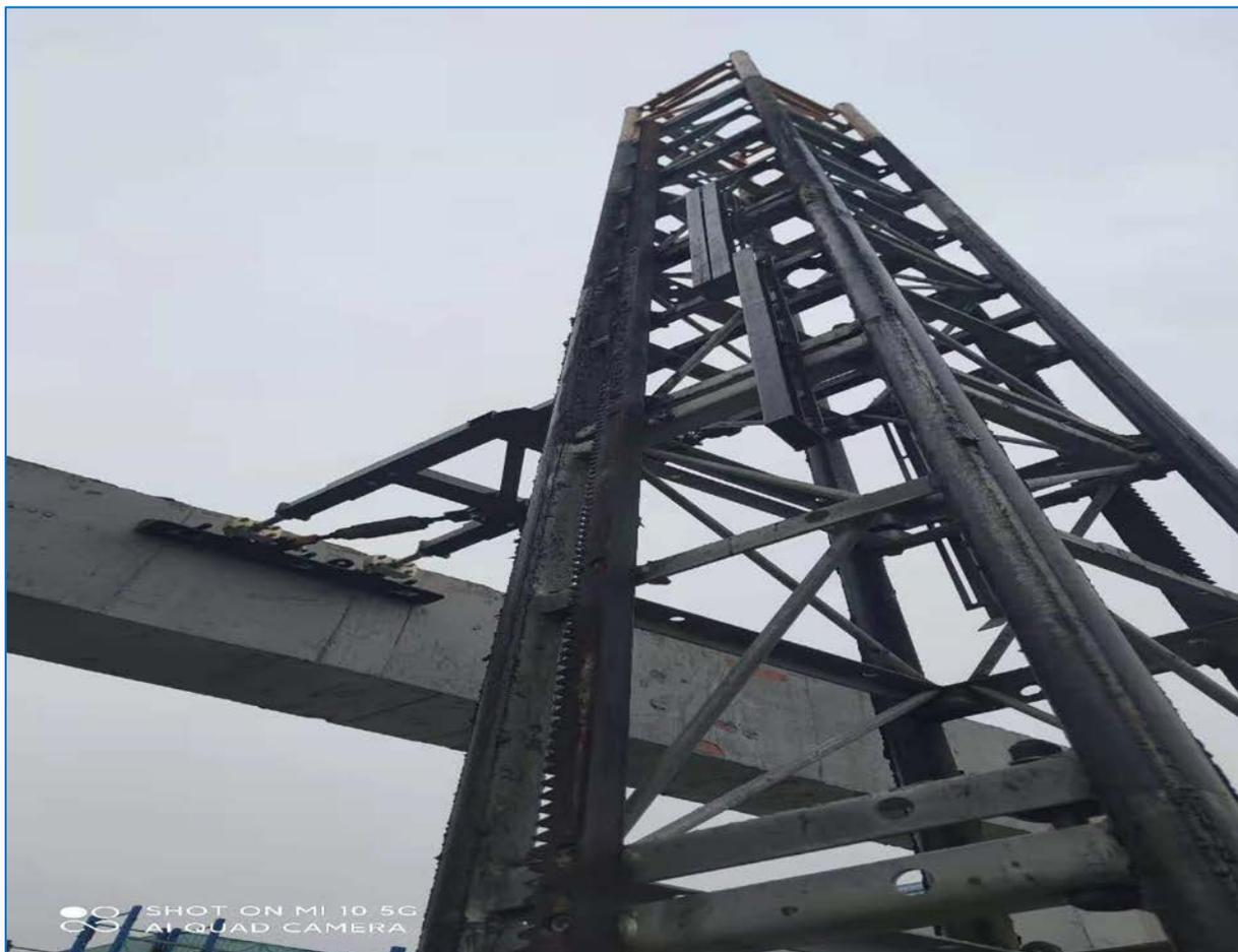
屋面施工期间有条件的项目应在花架梁等结构上安装附墙架，且上限位与上极限限位必须安装在最顶附墙架以下。
