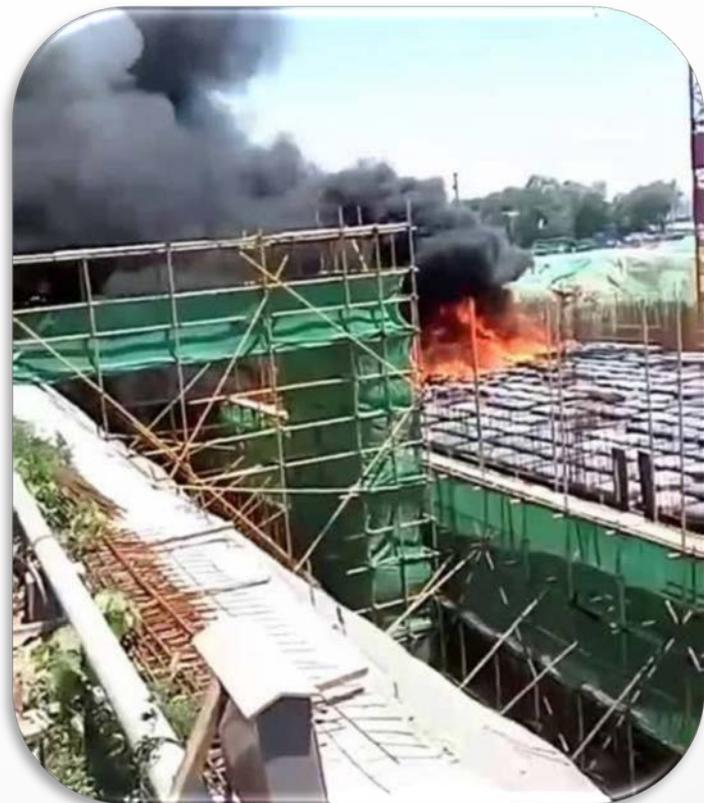
地下室模壳施工完成，施工人员使用电焊机焊接钢筋定位筋，造成模壳失火
