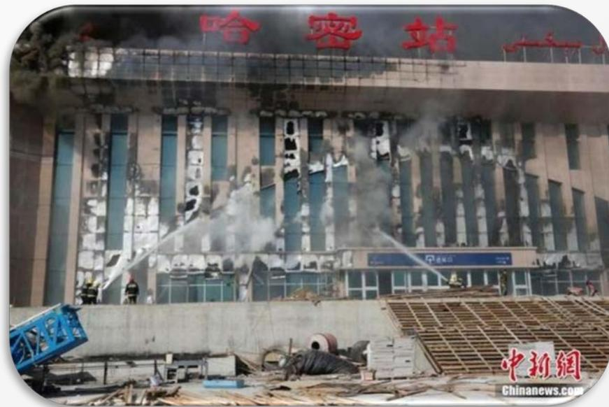
2014年8月21日17时19分，新疆哈密市新火车站（在建施工工地）发生火灾，该火灾因施工单位作业过程中不慎引燃外墙已完成保温层引发火灾。
