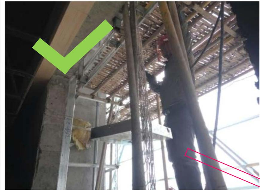
施工人员焊接幕墙龙骨，未设置接火盆。焊渣掉落，极易引燃下方可燃物
