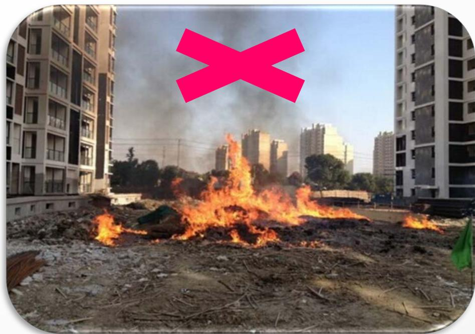
**保温下脚料长期堆放在施工现场空地，易发生火灾**
