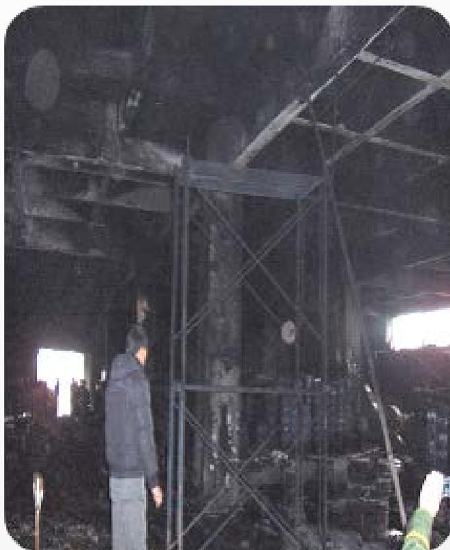
地下室砼浇筑完成后，在模壳拆除过程中，地下室模壳燃烧，发生火灾
