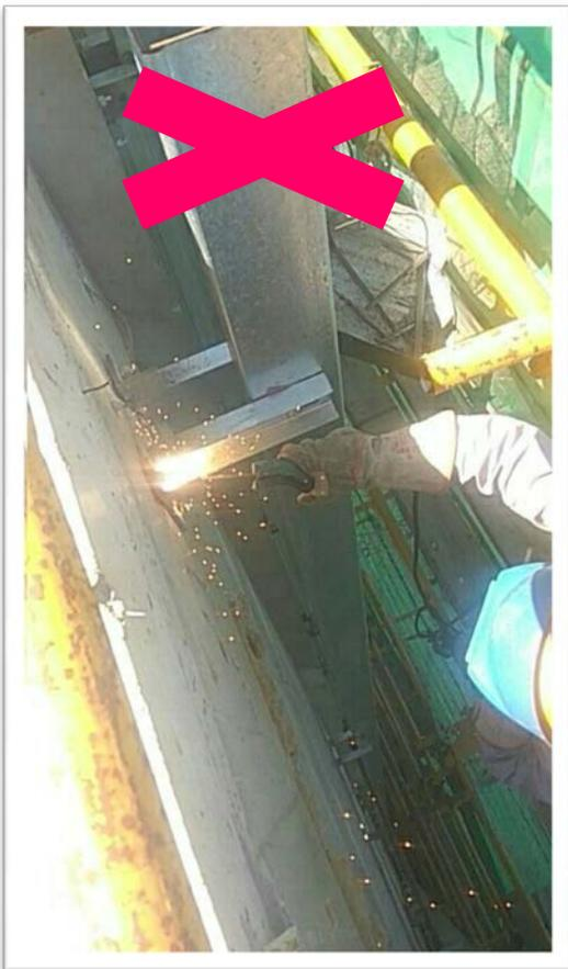
施工人员焊接幕墙龙骨，未设置接火盆。焊渣掉落，极易引燃下方可燃物
