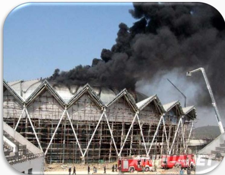
2008年11月11日，济南奥体中心体育馆施工现场屋面保温完成后，因明火作业引燃屋面保温，引发火灾。
