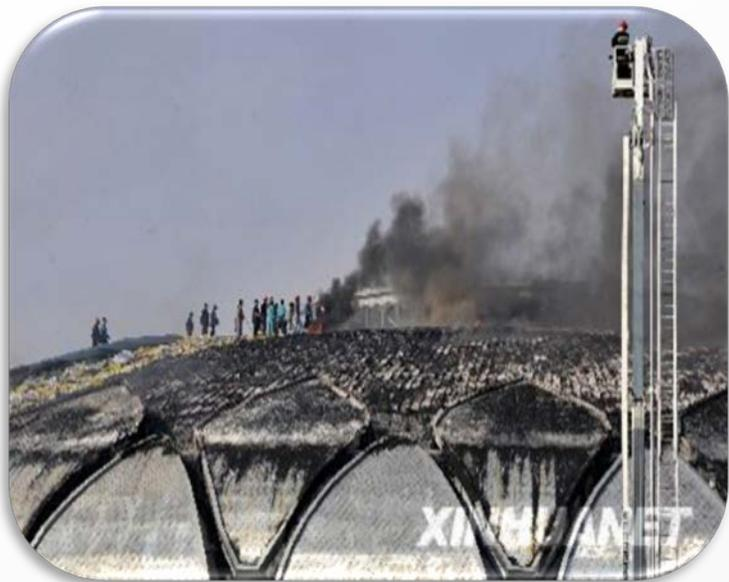
2008年7月27日，济南奥体中心体育馆施工现场屋面防水施工完成后，明火作业引燃防水材料，引发火灾；
