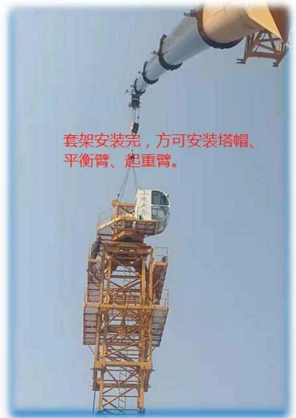
套架安装完，安装塔帽
