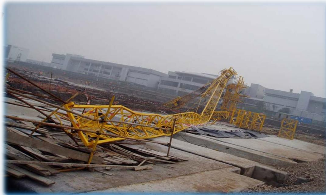
事故案例：某工地安装顶升时，因套架与下支座未可靠连接，导致塔吊倒塌。
