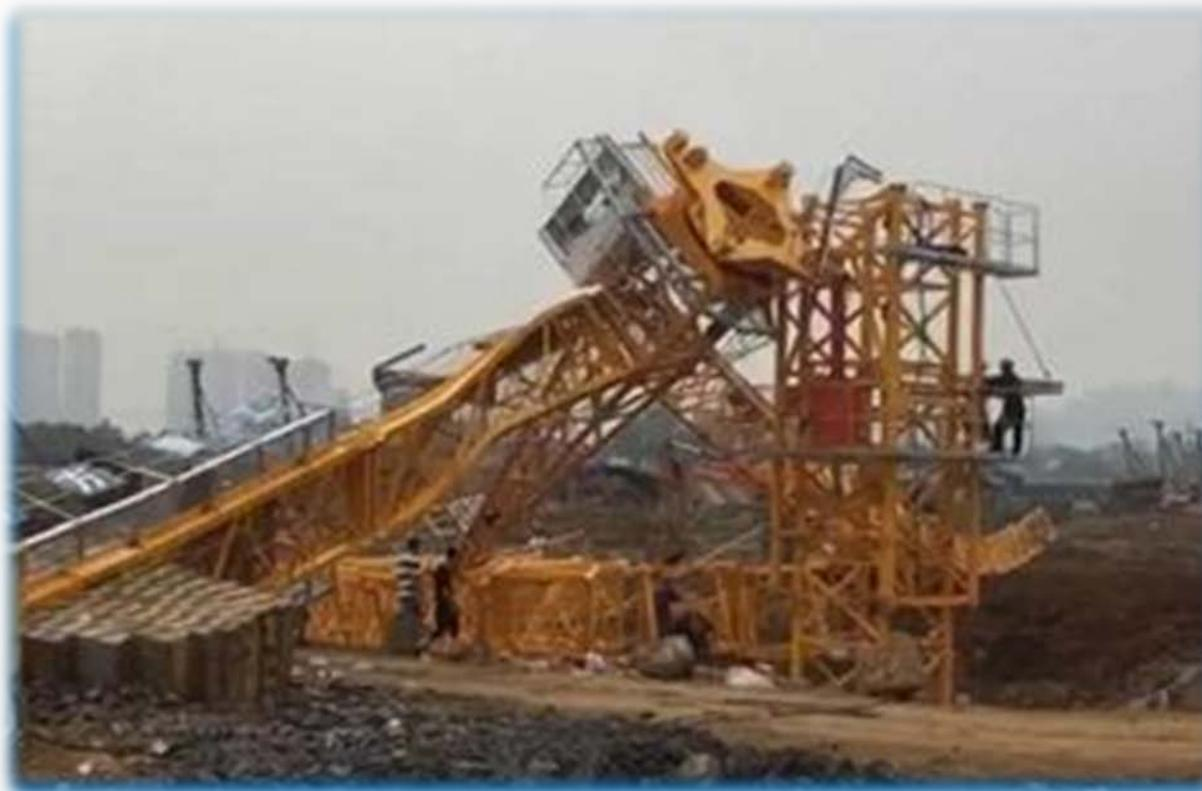
事故案例：顶升时，套架和回转未连接，导致塔机倾覆。
