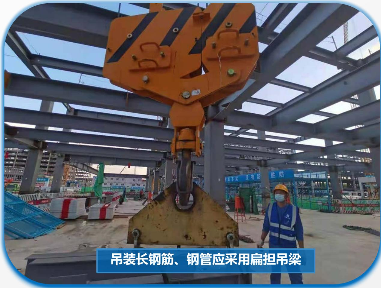
吊装长钢筋、钢管应采用扁担吊梁
