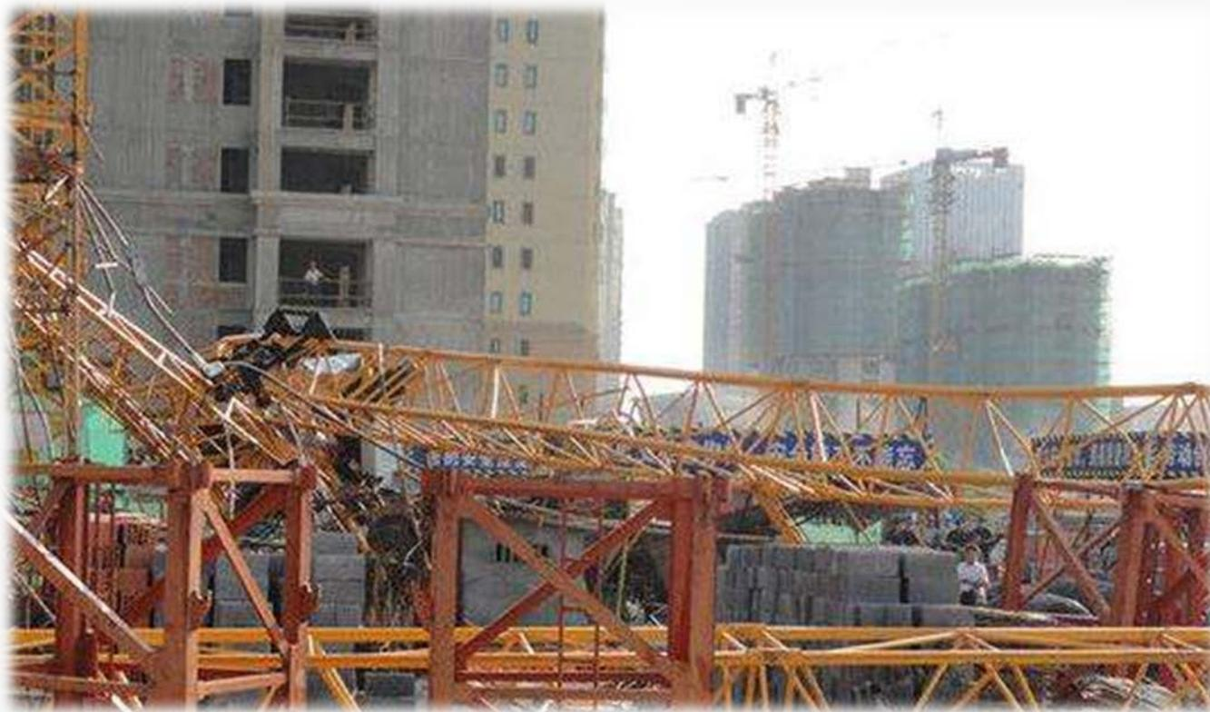
事故案例：此事故因安装、拆卸等工程业务分包给不具备安装、拆卸资质的公司进行非法施工，导致的塔机倒塌人员伤亡。
