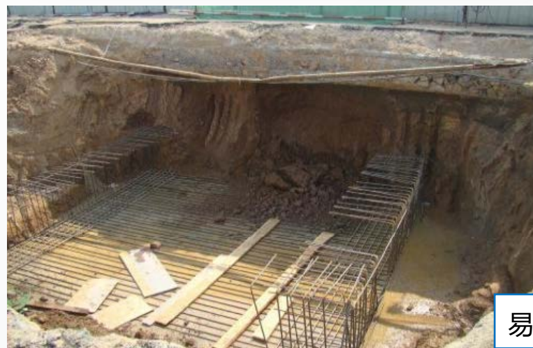
基坑深度不超过5m，没有基坑支护专项设计，未采取支护措施
