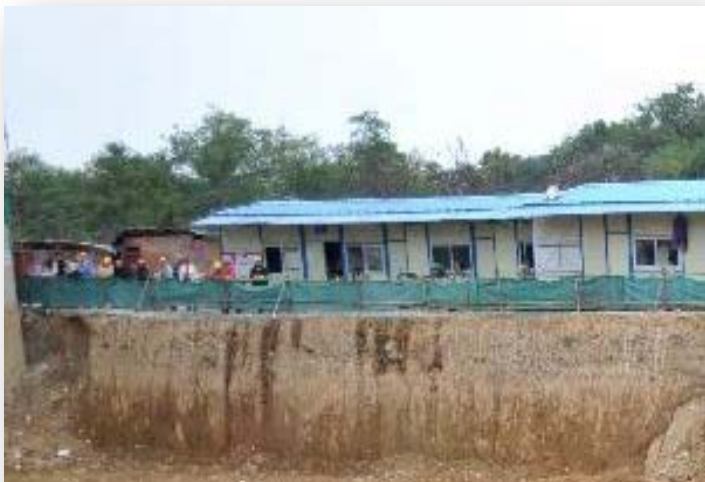
基坑深度不超过5m，没有基坑支护专项设计，未采取支护措施
