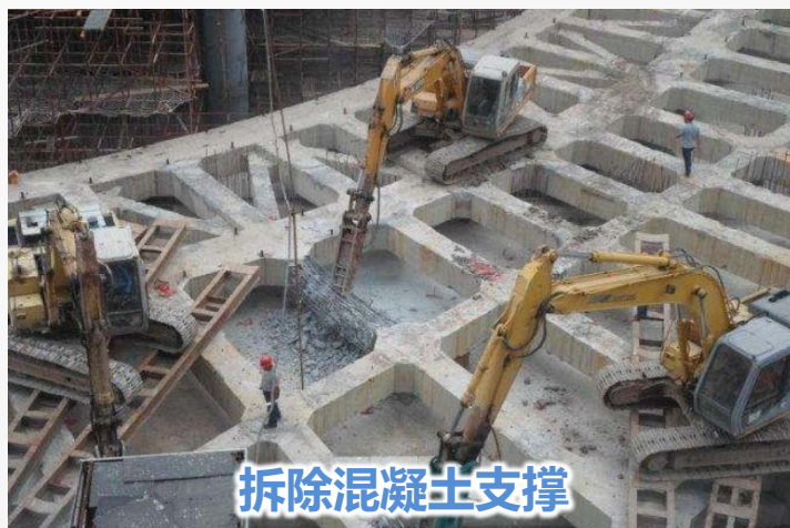
切割混凝土支撑
