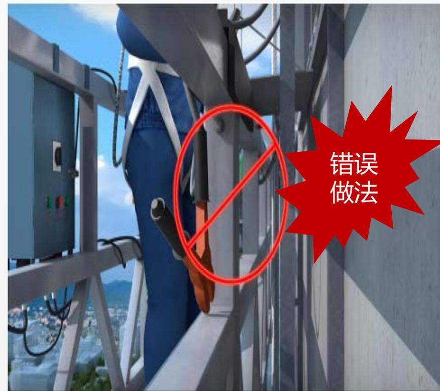
电焊钳搭挂在吊篮上
