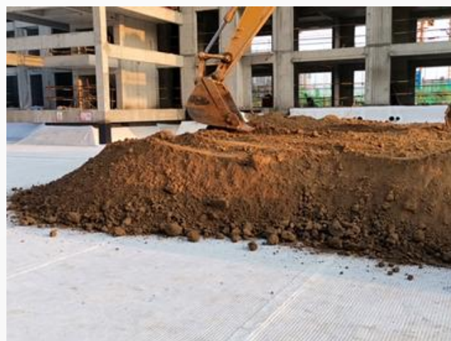
严格控制回填厚度
