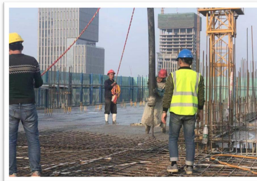
监理工程师旁站
